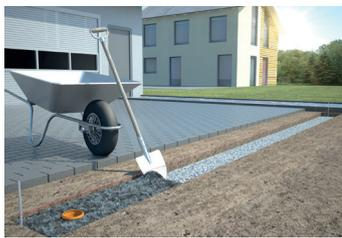
1. Graben ausheben. Tragschicht einfüllen und verdichten. Betonbett, 3 Teile Sand + 1 Teil Zement + 1 Teil Wasser, auf Tragschicht aufbauen.
