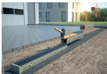
5. Die Reihe vervollständigen und die Bauteile eben ausrichten.
