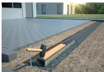
3. Rinnenstrang, Einlaufkästen auf das Betonbett aufsetzen. Bauteile plan ausrichten.
