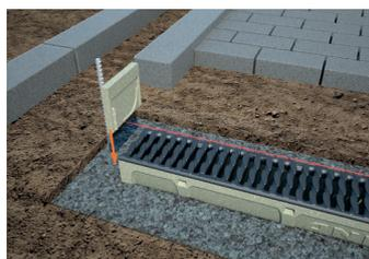
4. Stirnwände aufsetzen.
