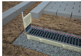
4. Stirnwände aufsetzen.
