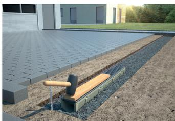
3. Rinnenstrang, Einlaufkästen auf das Betonbett aufsetzen. Bauteile eben ausrichten.
